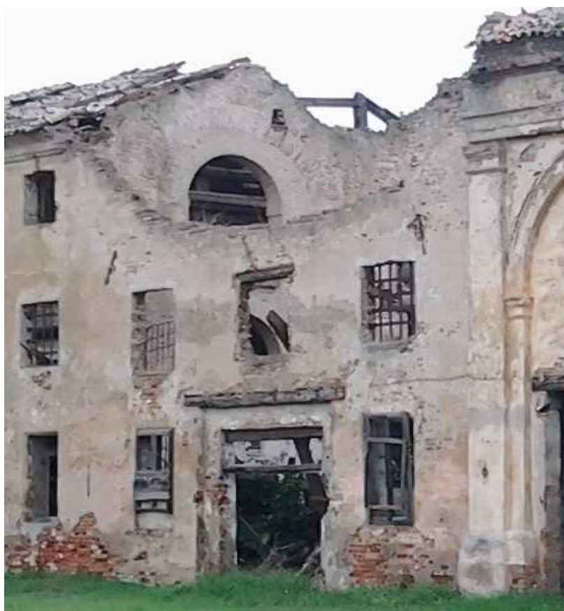
Figura 24: foto attuale del deposito per le granaglie
