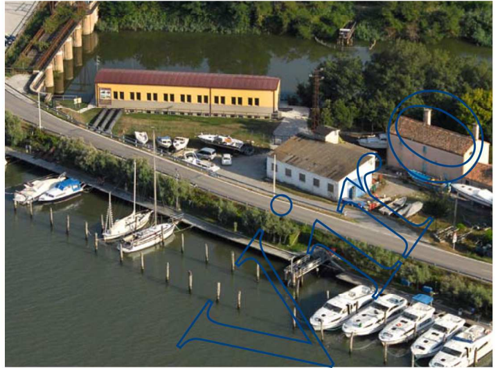
21. Veduta aerea Idrovora Chiavica Emissaria
