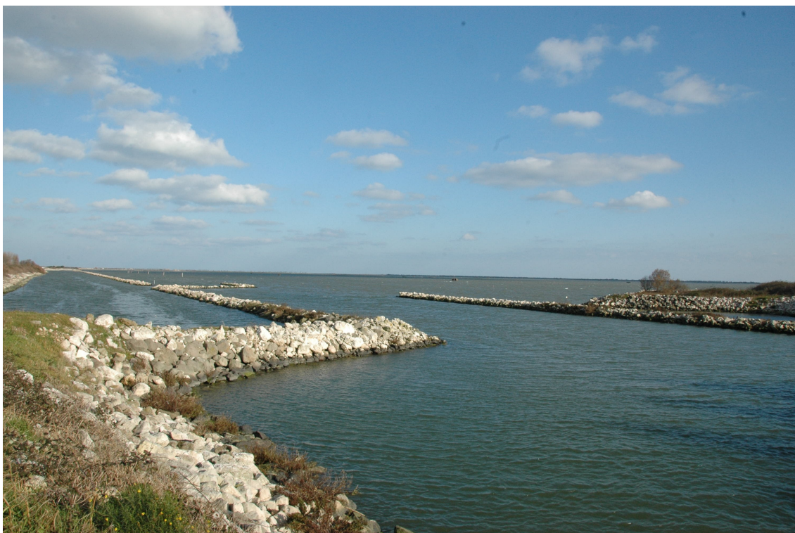
Illustrazione 3: dall'argine all'idrovora della Valle Bagliona verso la Laguna Vallona
